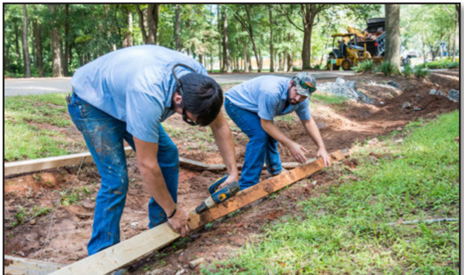
Avondale Subdivision culvert work
